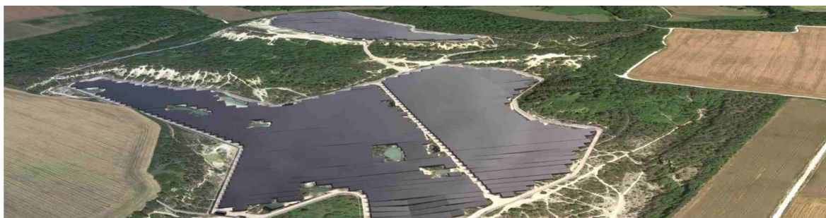
Projet parc panneaux photovoltaïques -Villey Saint Étienne
